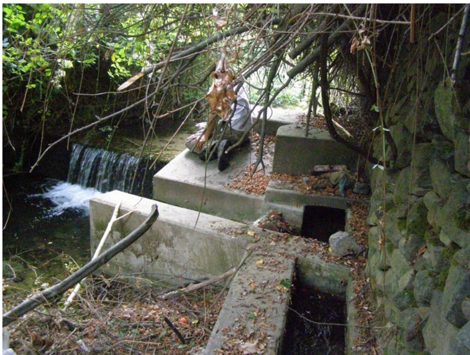
Εικόνα 8.6: Κατασκευή εκτροπής νερού (φωτογρ.: Τμήμα Αναπτύξεως Υδάτων, Κύπρος)
