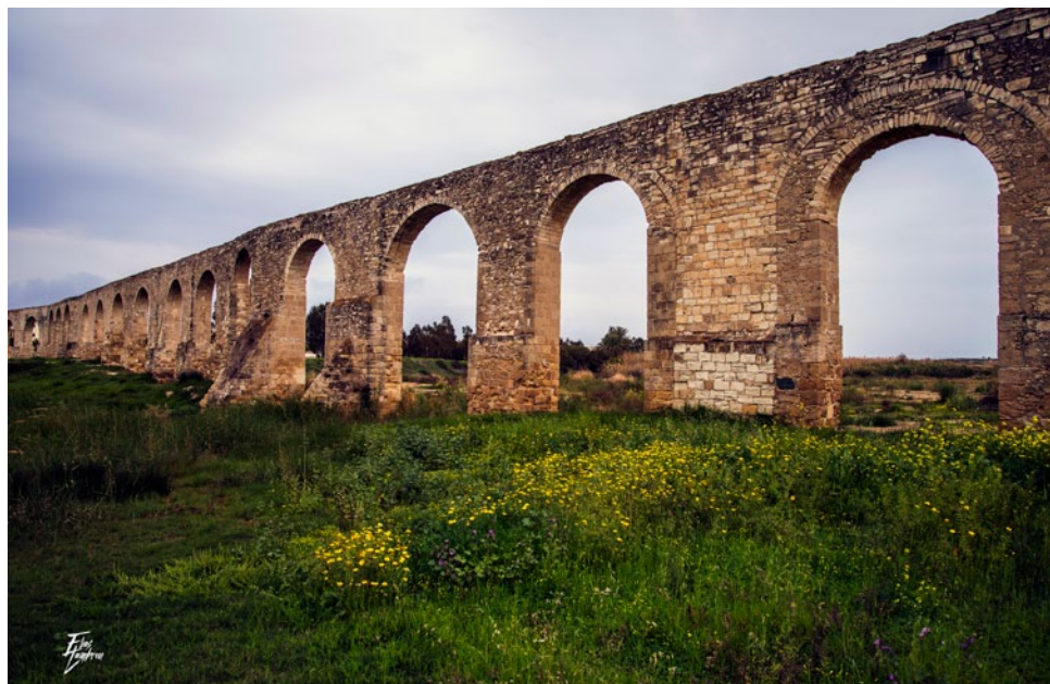
Εικόνα 4.12: Οι καμάρες Λάρνακας, τμήμα του υδραγωγείου της πόλης του Κιτίου, μέσω του οποίου γινόταν η μεταφορά του νερού από τις πηγές στην πόλη. (φωτογρ.: Η. Λάμπρου)
